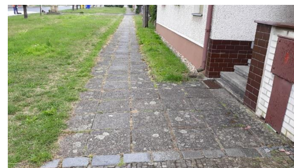
dřívější betonová velkoformátová dlažba 50x50cm
